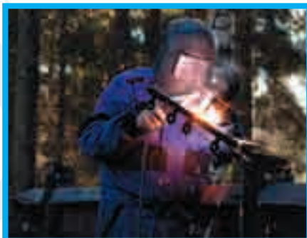
Údržbář při opravě oplocení The maintenance man repairing the fencing
