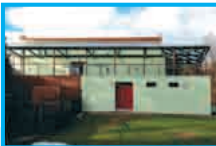
Přístavba pavilonu žiraf po dokončení The additional building of the house of giraffes after finishing
