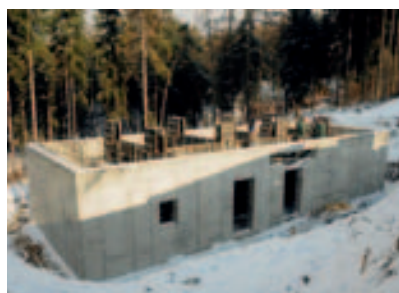
V roce 2010 byla zahájena stavba výběhů pro levharty mandžuské The construction of the enclosure for the Amur Leopards started in 2010
