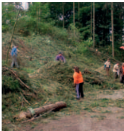
Těžba a vyklízení prostoru v místě stavby pavilonu pro levharty mandžuské Timber felling and clearing of the construction site of the Amur Leopard house
