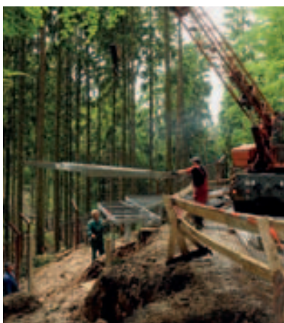
Stavba vyhlídkové terasy u výběhu vlků a medvědů Construction of the observation platform at the enclosure for the wolves and the bears
