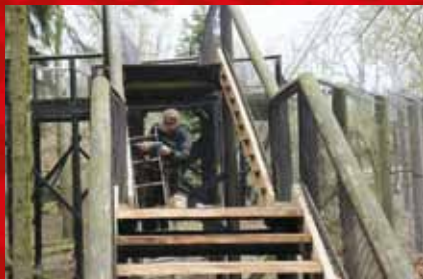
Oprava lávky ve výběhu rysů /Repair of the walkway in the enclosure for lynxes/
