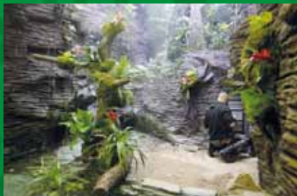
Poslední dokončovací práce v teráriu krokodýlů /Last finishing work in the terrarium with crocodiles/
