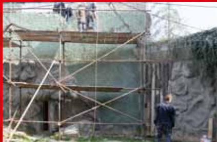
Oprava omítek ve výbězích pavilonu šelem /Repair of the plasters in enclosures of the carnivore pavilion/
