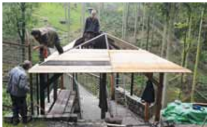
Stavba nového dřevěného vstupního objektu na lávku ve výběhu makaků /Construction of the new wooden entrance object on the footbridge in the enclosure for macaques/
