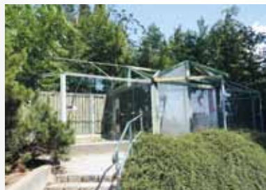
Oprava ubikace pro kočky /Repairing cats sleeping quarters/
