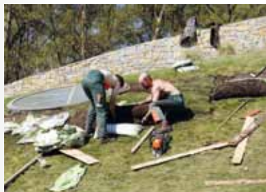
Oprava trávníku nad vstupem do zoo /Repair of lawn above the zoo entrance/
