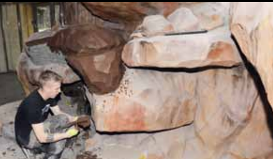
Výroba umělých skal /Making artificial rocks/
