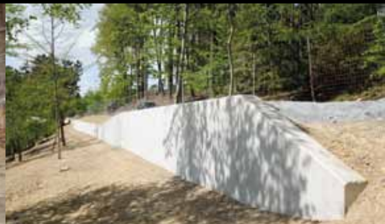
Opěrná zed' po dokončení /Retaining wall after completion/
