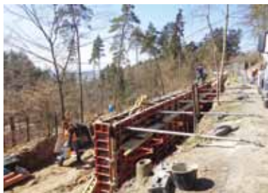
Stavba opěrné zdi amerického safari /Construction of the Safari retaining wall/
