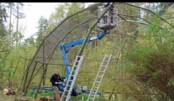
Oprava pletiva na obří voliére /Repairing mesh on a giant aviary/
