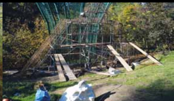
Kostra umělé skály uvnitř voliéry /Artificial rock skeleton inside the aviary/
