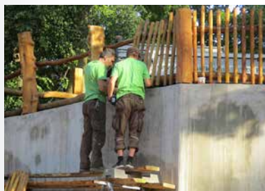
Instalace nového oplocení /Installation of new fence/
