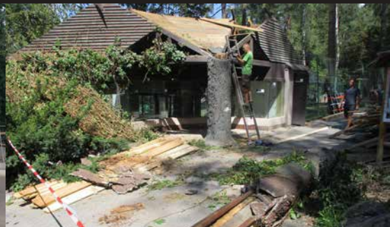
Oprava střešky u kočkodanů /Roof repairing on Patas monkey house/
