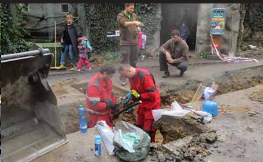
Započala rekonstrukce inženýrských sítí /We started reconstruction of utility networks/
