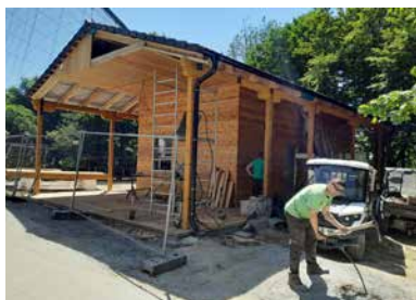
Stavba grilu U Lvů /Construction of a new restaurant/
