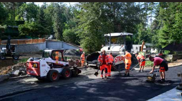
Asfaltování cest po výkopech /Asphalting of roads/
