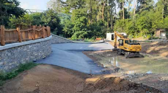
Akce „Hospodaření s dešťovou vodou“ /Management with the rainwater/
