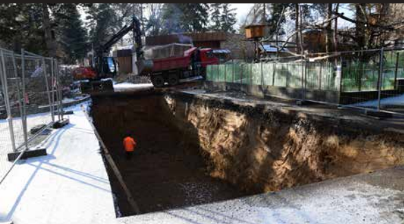
Výkop pro podzemní nádrž na vodu /Preparing of underground water reservoir/
