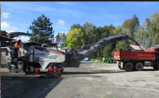
Frézování asfaltových ploch /Road milling/
