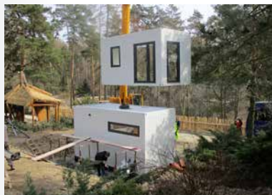
Stavba kavárny U Kozíček /Construction of a new cafe/
