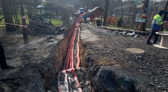
Práce na inženýrských sítích pokračovaly /Work on engineering nets continued/
