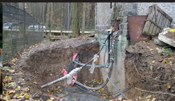
Opravy centrální vodárny /Reparations of waterworks/
