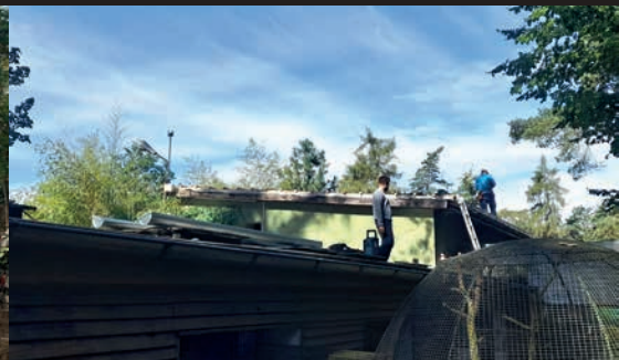
Oprava střechy Pavilonu opic /Roof repairing of Primates pavilion/
