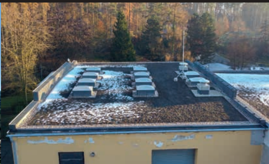
Střechy na zimovišti po opravě /Roofs on winter quarters after repair/
