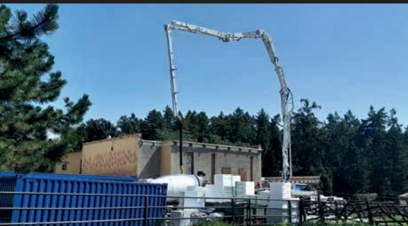
Betonáže střech na zimovišti /Concreting roof on winter quarters/
