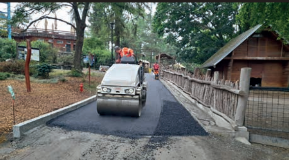
Na většině výkopů byly položeny nové povrchy /Most excavation was covered with new surfaces/
