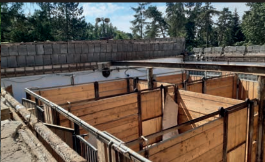
Stáje antilop po odstranění střechy /Stable of antelopes after roof removal/
