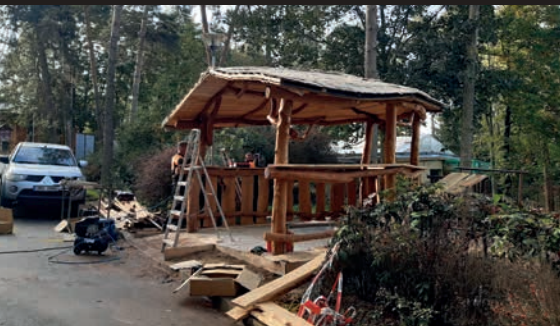
Stavba altánu u výběhu mravenečníků /Building of gazebo at Giat Anteaters enclosure/
