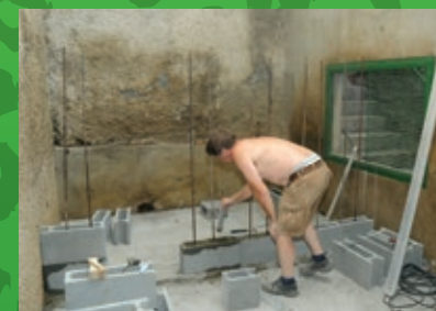
Výstavba porodního kotce pro tygřici /The construction of a labour cot for a female tiger/
