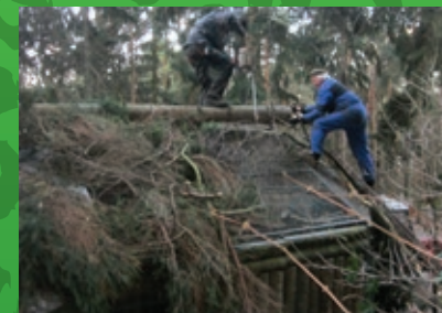
Odstraňování následků větrné smrště /Removal of the damage left after a whirlwind/
