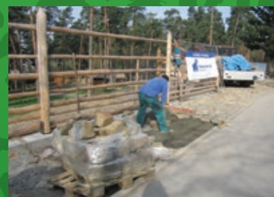
Dláždění chodníku před výběhy safari /Paving outside the enclosures of our safari/
