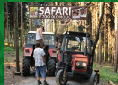
Stavba uvítací brány do euroasijského safari /The construction of the welcome gate to Eurasian safari/
