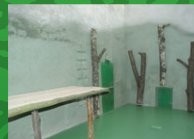
Opravená vnitřní ubikace tygrů ussurijských /The repair of the inner space of the kennel for Siberian tigers/
