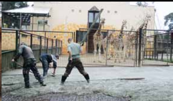
Betonování nájezdu u výběhu žiraf /Reconstruction of giraffes enclosure/
