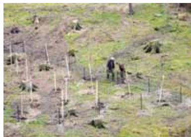
Výstavba oplocenky ve výběhu medvědů a vlků /The construction of fence in the outdoor enclosure/
