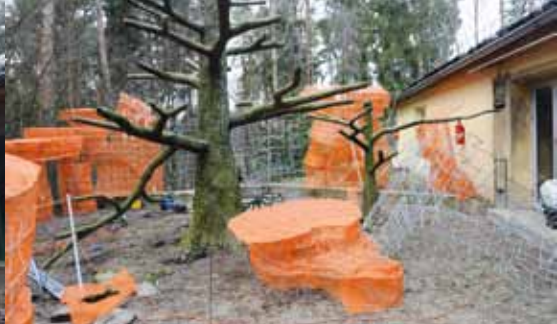
Výstavba výběhu Orinoko /The construction of the Orinoko outdoor enclosure/
