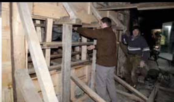
Betonování vnitřních stěn akvária /Applying concrete on the inner walls of the aquarium/
