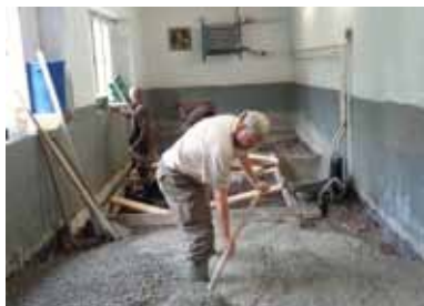
Oprava ubikace pro plameňáky /Repairs at the flamingo enclosure/
