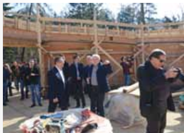
Představení stavby pavilonu Kalahari /Kalahari pavilion controlling day/
