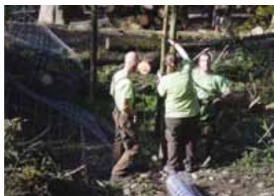
Oprava oplocenky u kozorožců /Repair of fencing/
