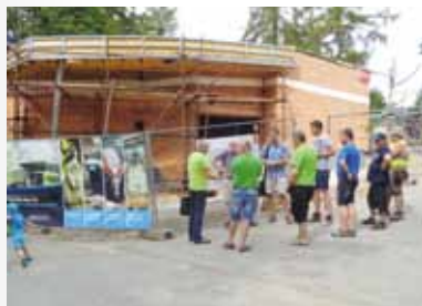
Kontrolní den na stavbě /Inspection day at the construction site/
