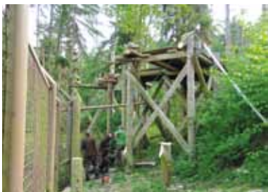
Bourání lávky u medvědů /Demolition of a platform in the bear enclosure/
