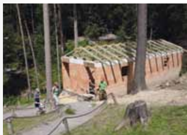
Stavba odchytového zařízení pro makaky /Construction of the capture device for macaques/
