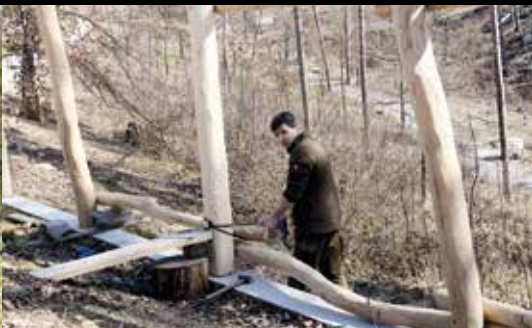
Montáž plotu ve výběhu vlků /Installation of a fence in the wolves' paddock/
