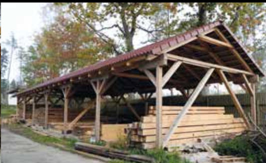
Přístřešek na uskladnění řeziva /Timber shed/
