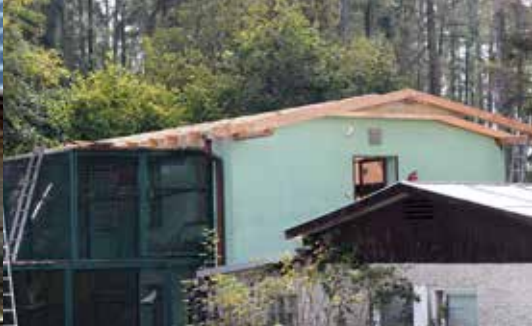
Oprava střechy na zimovišti ptáků /Repairing the roof for wintering birds/
