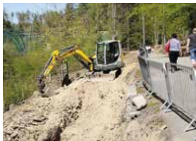
Stavba opěrné zdi ve výběhu kozorožců sibiřských /Construction of a retaining wall/
