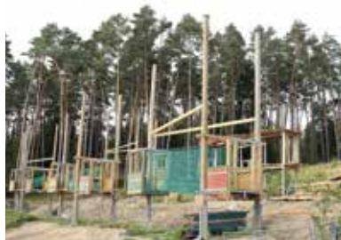
Stavba nového Lanáčku /Construction of the new Lanáček/
