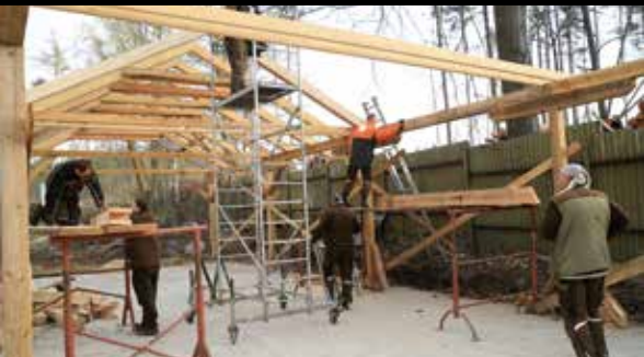
Stavba přístřešku pro řezivo /Construction of a timber storage facility/
