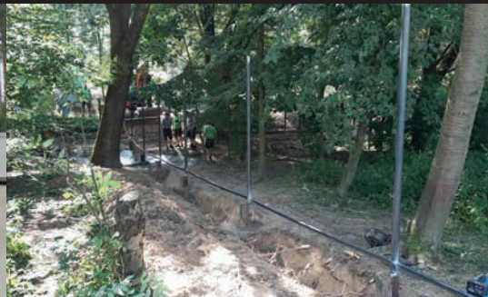
Oprava plotu ve výběžích jeřábů /Fence repair in cranes enclosure/
