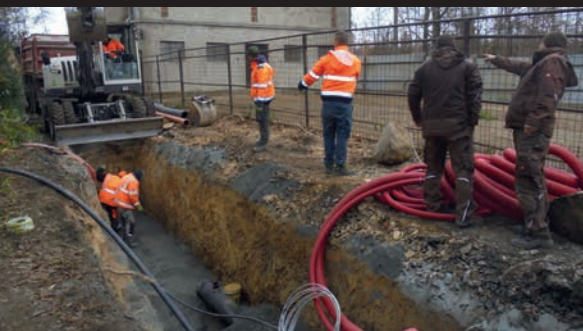
Pokračování rekonstrukce inženýrských sítí /Reconstruction of utility networks continued/
