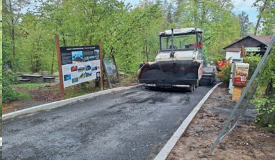
Byly položeny nové živiničné povrchy /The new bituminous surface was laid/
