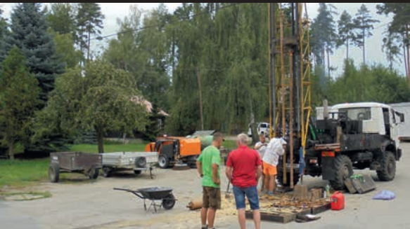
Průzkumné vrty v hospodářském dvoře /Exploration wells on the yard/
