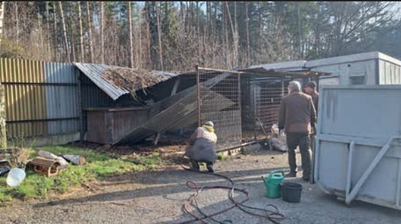
Demolice starých kotců /Demolition of old stall/
