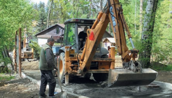
Finální práce na inženýrských sítích /Finishing of utility networks/
