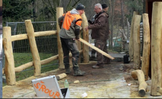
Oprava vyhlídky u infokiosku /Reconstruction of a view/
