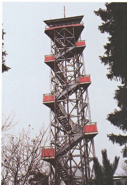
Rekonstrukce vyhlídkové věže bude dokončena v roce 2000
