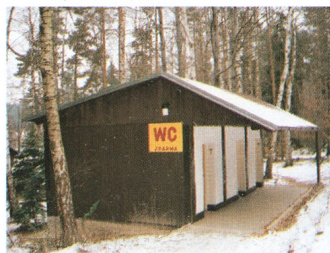
WC na dětském hřišti bylo jednou z větších akcí roku 2000 The new WC at the playing field
