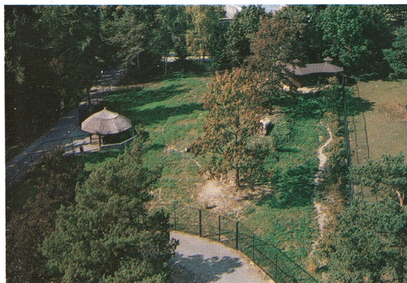
Pohled na dokončený výběh a ubikace gepardů The new house and enclosure for cheetahs
